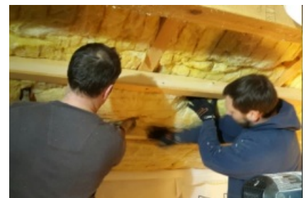
Arbeiten am Innenausbau
