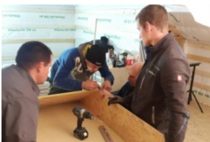
Arbeiten am Innenausbau
