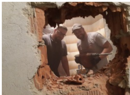
Erster Mauerdurchbruch im Altbestand
