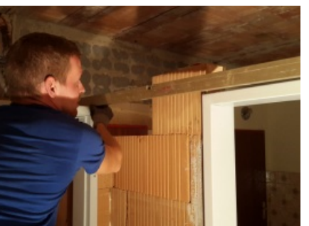
Erste Zwischenwände im Sanitärbereich
