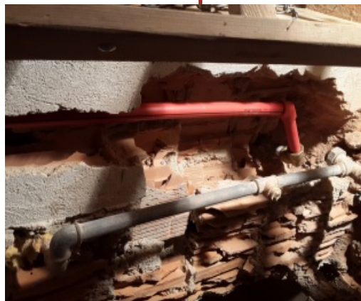
Austausch von Wasser- und Stromleitungen
