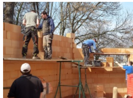
Aufmauern der neuen Außenwände
