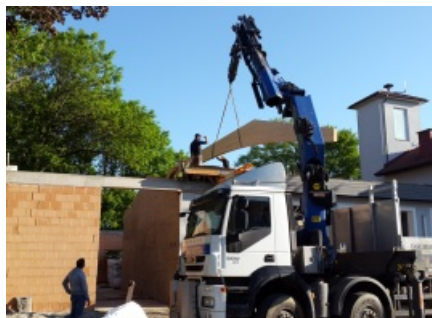
Aufsetzen Dachstuhl & Leimbinder
