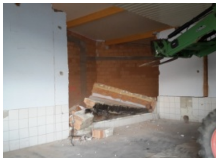
Durchbruch: Die alte Außenmauer fällt
