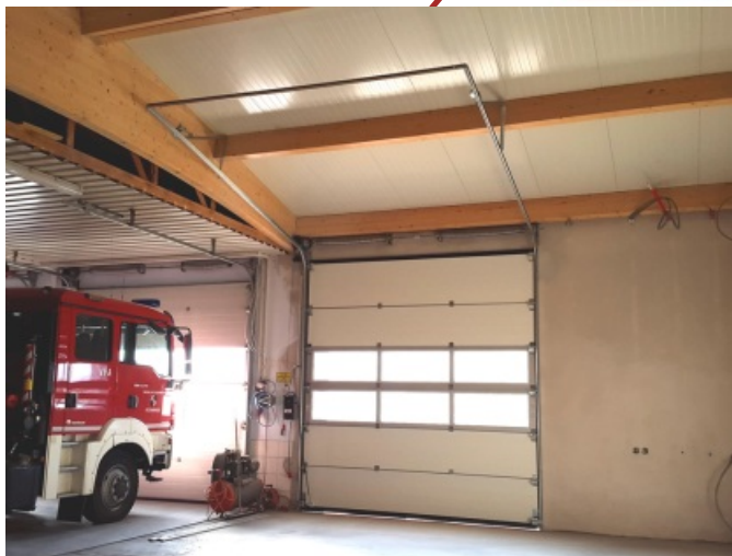
Fahrzeughalle Die Erweiterung ist fast abgeschlossen
