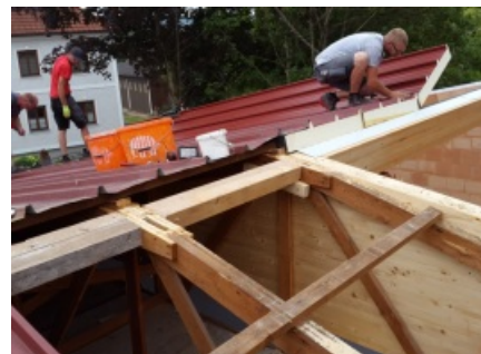
Verlegen der Dachpaneele
