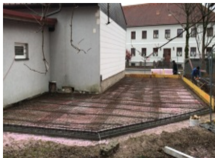
Fundamentplatte für Hallen-Zubau
