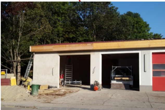
Zubau mit Außenputz und Sanierung Holzfront
