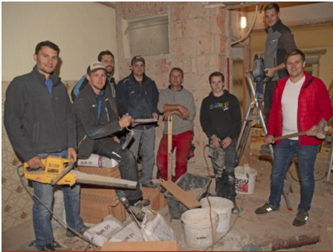
Großbaustelle auch im Innenbereich
