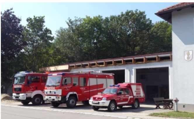
Instandsetzung auch der bestehenden Fahrzeughalle
