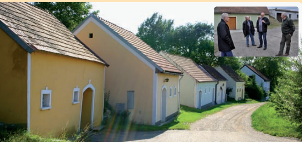
Gr. Bild: Kellergasse Judenau-Baumgarten, Kl. Bild: Begehung mit DI Kalch und Kellerbesitzern.
