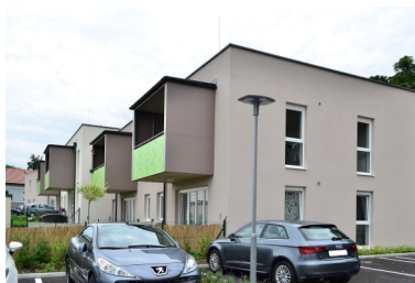
Neubau bei Lagerhaus
