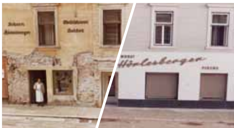
Umbau und Fassadenerneuerung 1964
