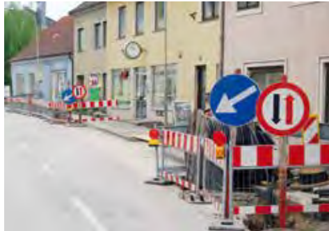
Nicht erwünscht, aber notwendig – Wasserleitungsbaustelle entlang der Linzer Straße
