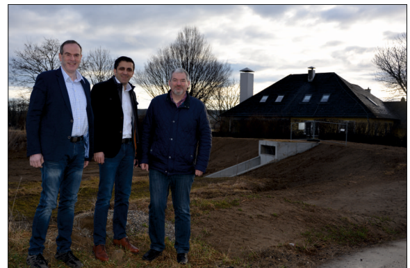
Umwelt-GR Josef Keck, Bürgermeister Erwin Bernreiter und OV Roman Heiden vor dem neuen Hochwasser-Sammelbecken in Sonnberg
